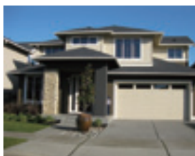
シアトルの住宅展示場
