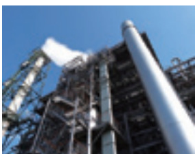
川崎バイオマス発電所
