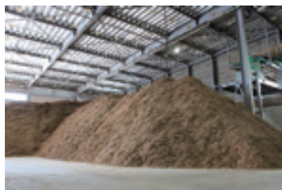
バイオマス発電所に併設しているチップヤード
