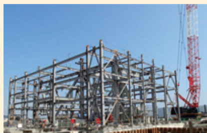
紋別バイオマス発電所建設現場
